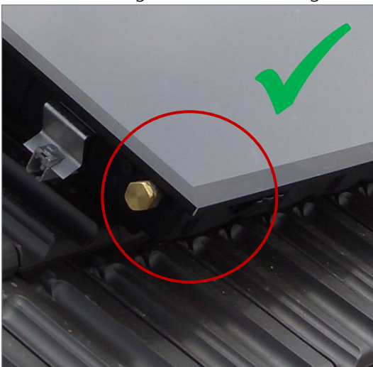
Bild 1 - Gehrungsschnitt in Ordnung
